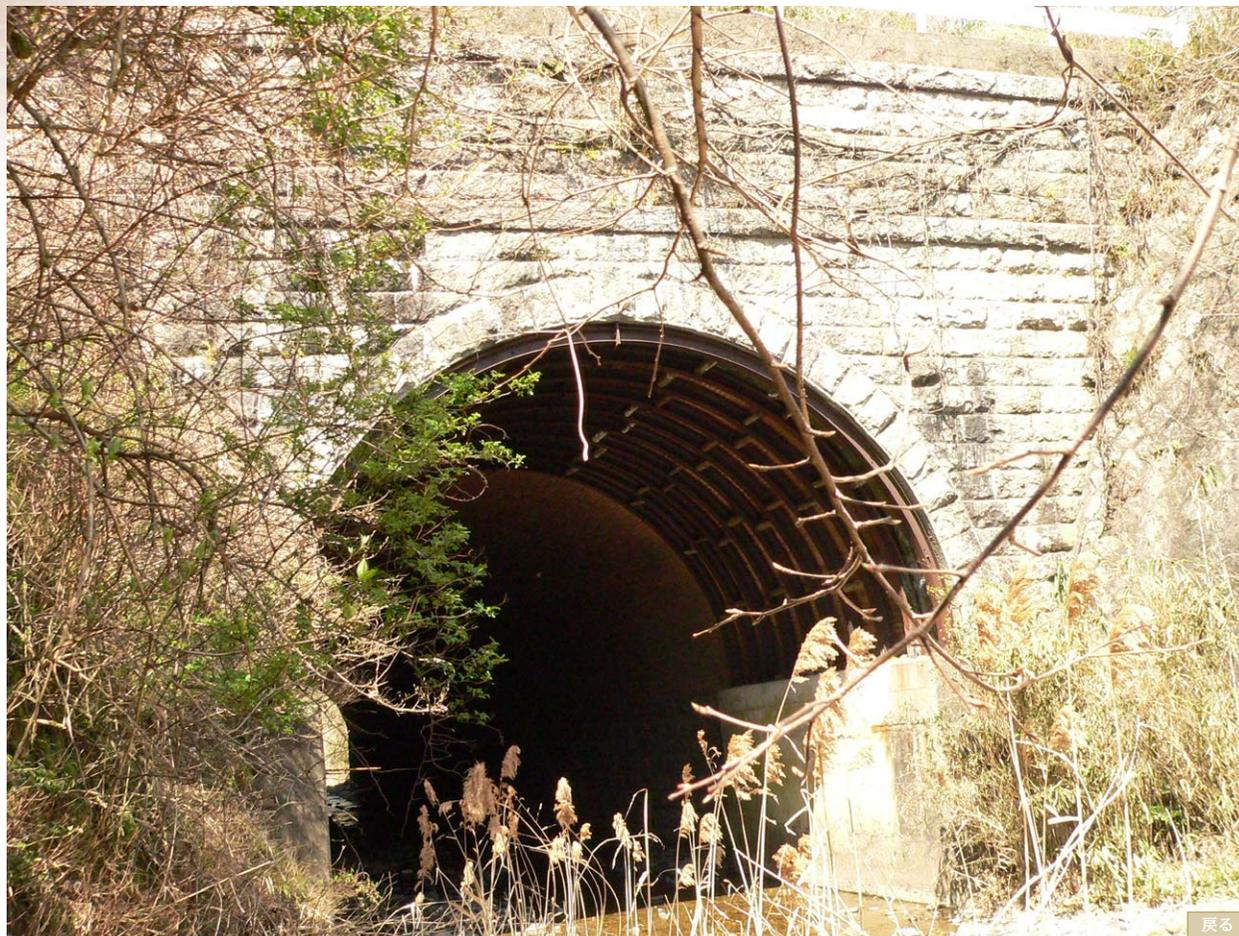
東側坑口。こちら側の坑内煉瓦は補修を受けている。
