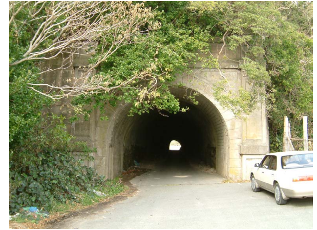
納屋隧道 国東口
