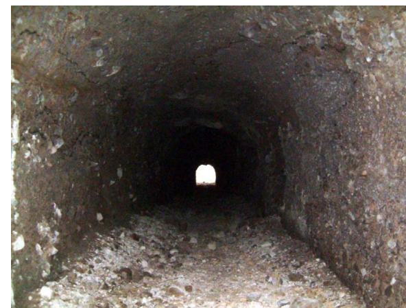
内迫隧道 内部
