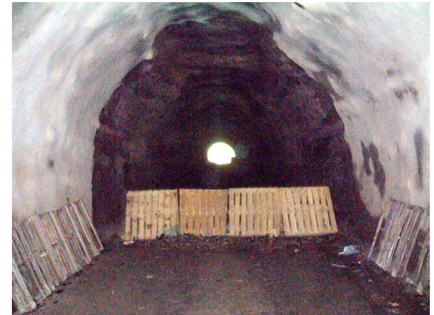
藤ノ木隧道 内部
