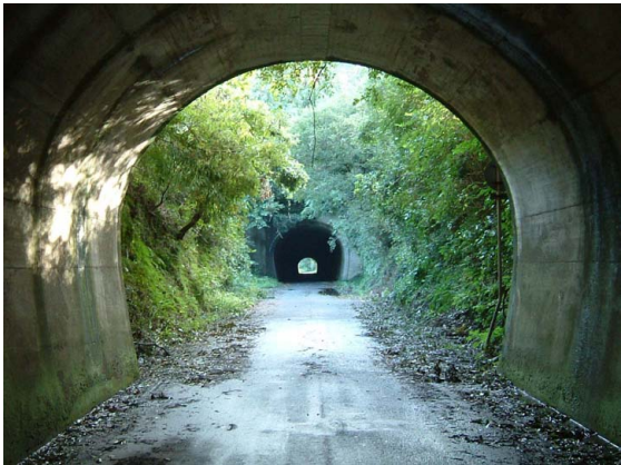
⑦ かんだや隧道
