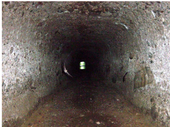
多量の蝙蝠が生息する初代隧道。
