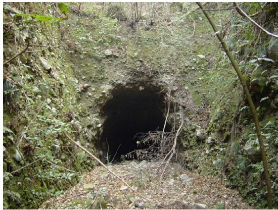
竹田津隧道（初代）（明治34年頃竣工）
