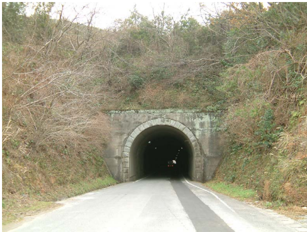
妙見隧道 豊後高田口
