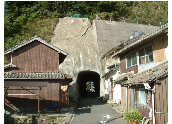
⑨ 貴船隧道
