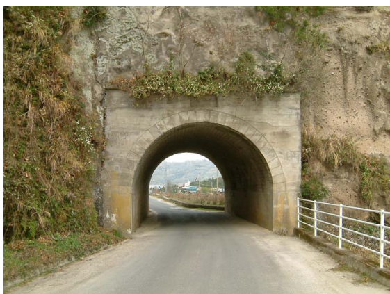
二代目・箕ヶ岩隧道 昭和10年6月竣工。昭和45年頃に埋立地を通る新道が開通し旧道となる。
