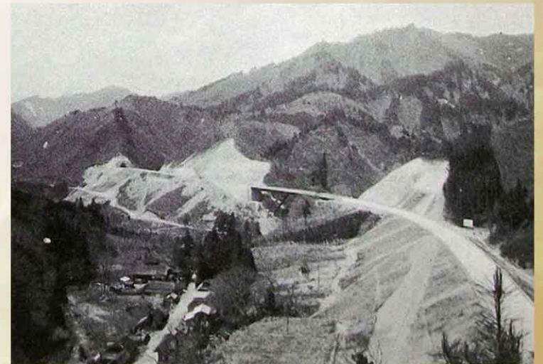
完成間近の国道13号バイパス。中央に西川橋、その奥に大滝第二トンネル、左下に旧国道と大滝の町並みが見える。右下に写っているのが、補償工事で開削された短絡農道。かなりの幅員があったことが分かる。完成記念パンフレット「萬世大路」より引用（提供 鹿摩貞男様）
