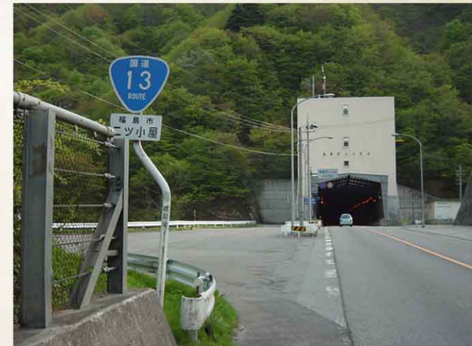
東栗子トンネル東口にある標識には「ニッ小屋」の地名がある 2004.05
