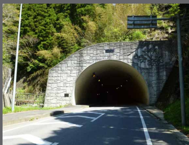
現「平田トンネル」富津方坑口と旧道(左側の 柵のあるところ)の分岐点です。
