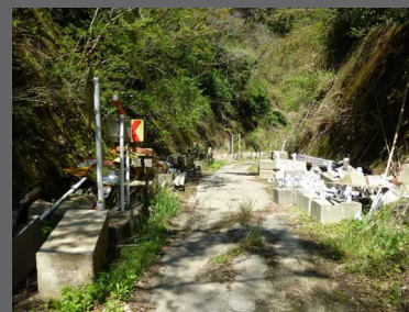
平田隧道富津方の切通しです。廃材置き場と 化しています。
