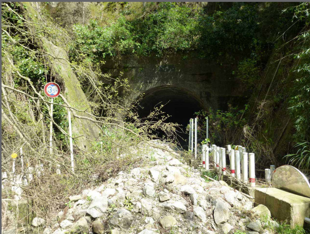
平田隧道富津方坑口です。現トンネル工事関係の廃材や旧道のカーブミラー等が置かれています。
