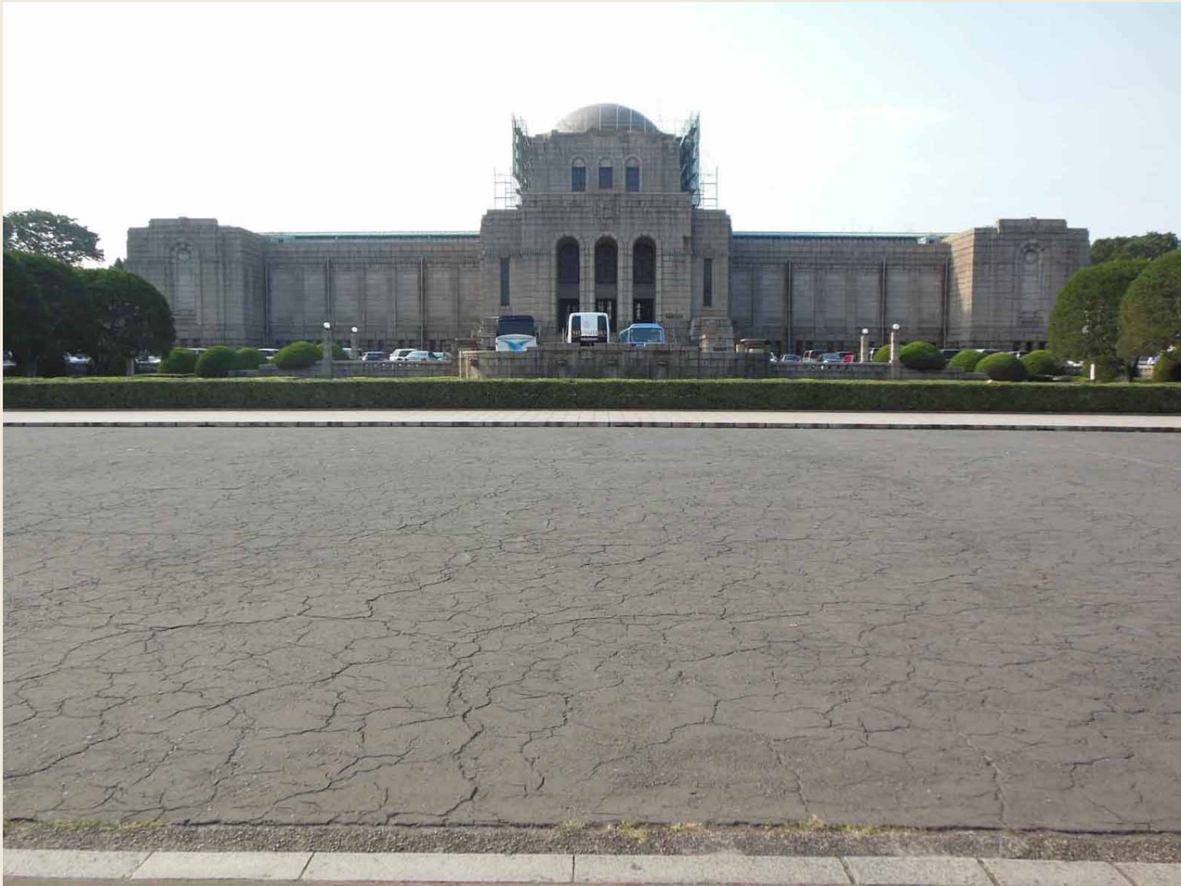
絵画館前の広場。広場のほとんどが当時の舗装です。
