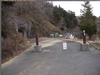
▲旧山伏隧道の山中湖側です。正面には以前食堂のようなものがあったと記憶しておりますが。
