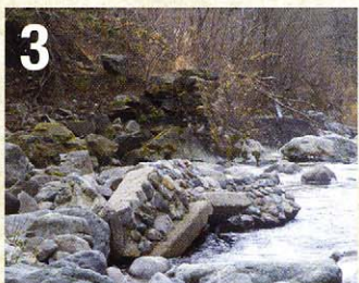
3 残り3km地点付近で、ほとんど路盤は川の中へ。激流がコンクリートの路肩を侵し、道全体を川の中へ引きずり込んでしまったのだ。こんな廃道、そうは見られない。
