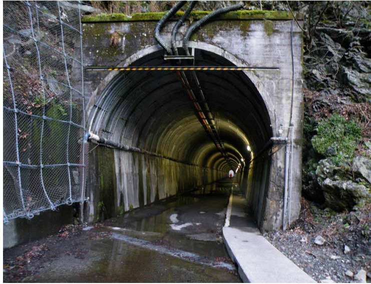
全長200mほどの天子トンネルも、拡幅はされているが、元は寸又川専用軌道（林鉄）の隧道。この開通で、はじめて寸又峡の奥にモータリゼーションがもたらされた。
