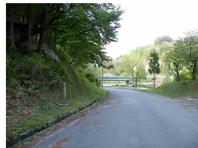
左の山手に見えるのが宇津明神で、奥の立派な橋は旧道を跨ぐ現国道だ。
