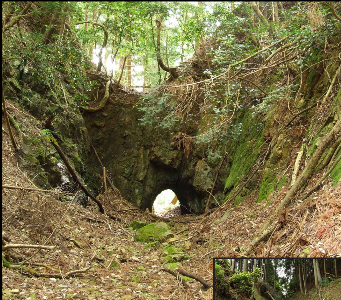
千原峠隧道南口（遠阪側）
