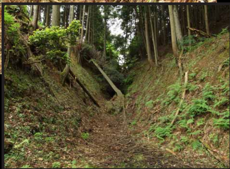
千原峠隧道北口（千原側）
