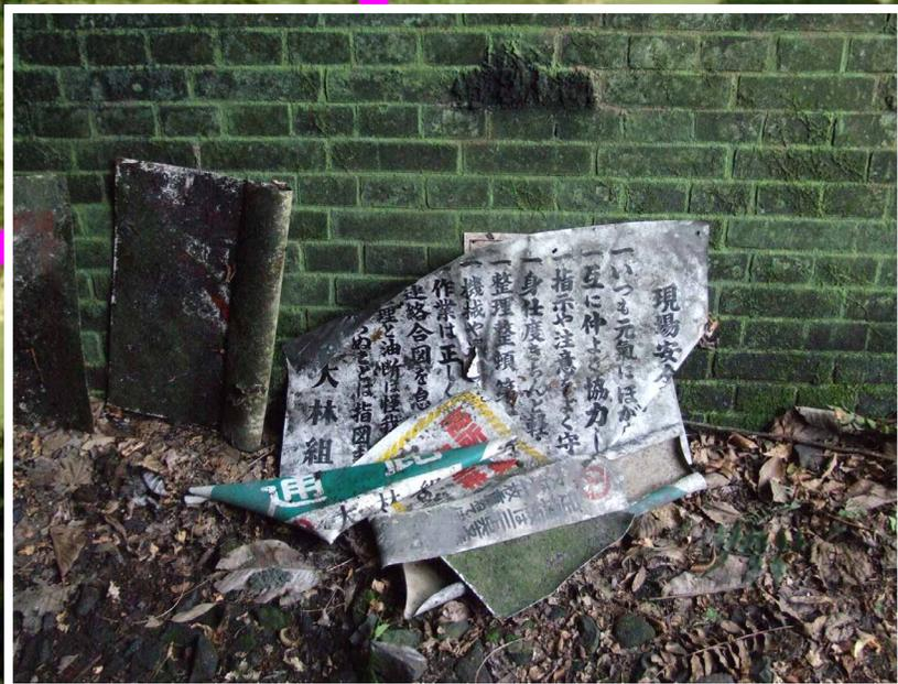
引き返して、再び名古屋側の入り口へ。玉野四号トンネルはその長さに比例するかのようにな大変な難工事で、建設中に崩落事故を何度も起こし、途中で設計変更さえなされているとか。トンネル脇の草むらにはその時に出たと思われる煉瓦の残骸が多量に打ち捨てられているし、坑門工に見える煉瓦アーチの巻数もこの隧道だけ7枚になっています（再生委員会はこうした技術的・歴史的調査もしっかりやっているのです。会員のなかには元国鉄職員や中部産業遺産研究会のメンバーもおられます）。
