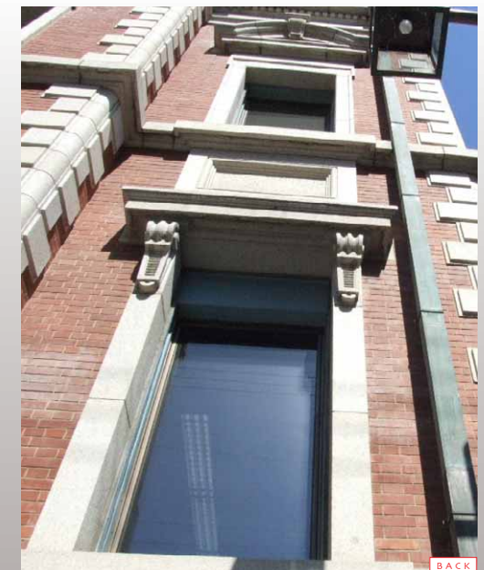
設計：吉井茂則、三橋四郎（逓信省常務課）。日本で初めてファザード保存を行なった建物
