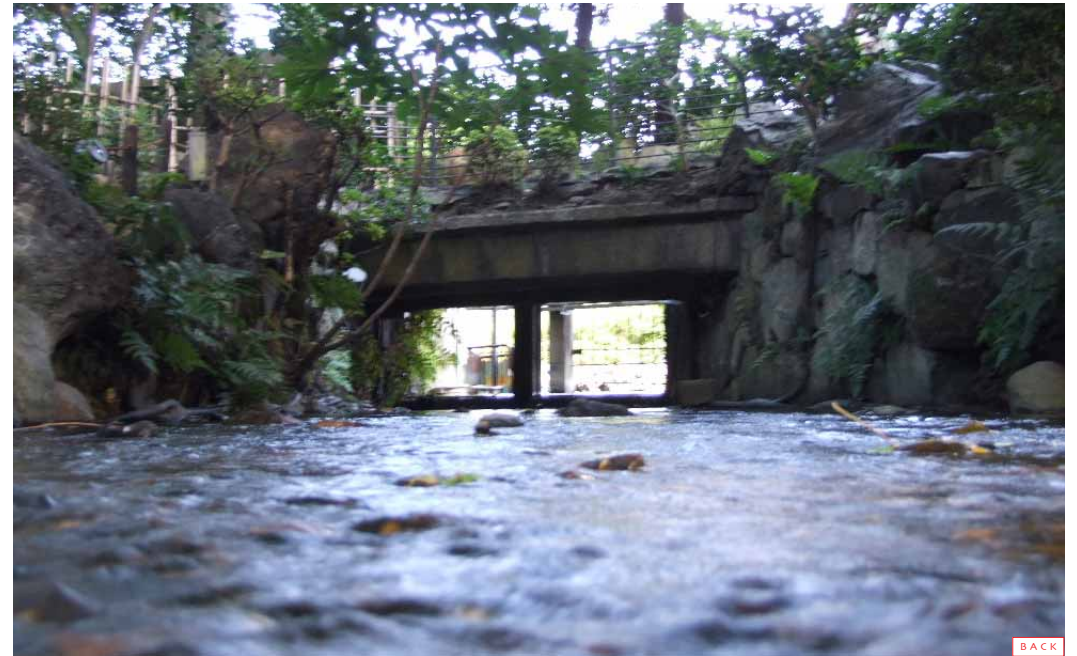
庭園内から取水口を撮ってみる。取り込まれた水は…
