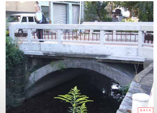
コンクリートアーチは榎橋という名前だった。板状のアーチ橋で、表面は洗い出しの化粧コンクリート
