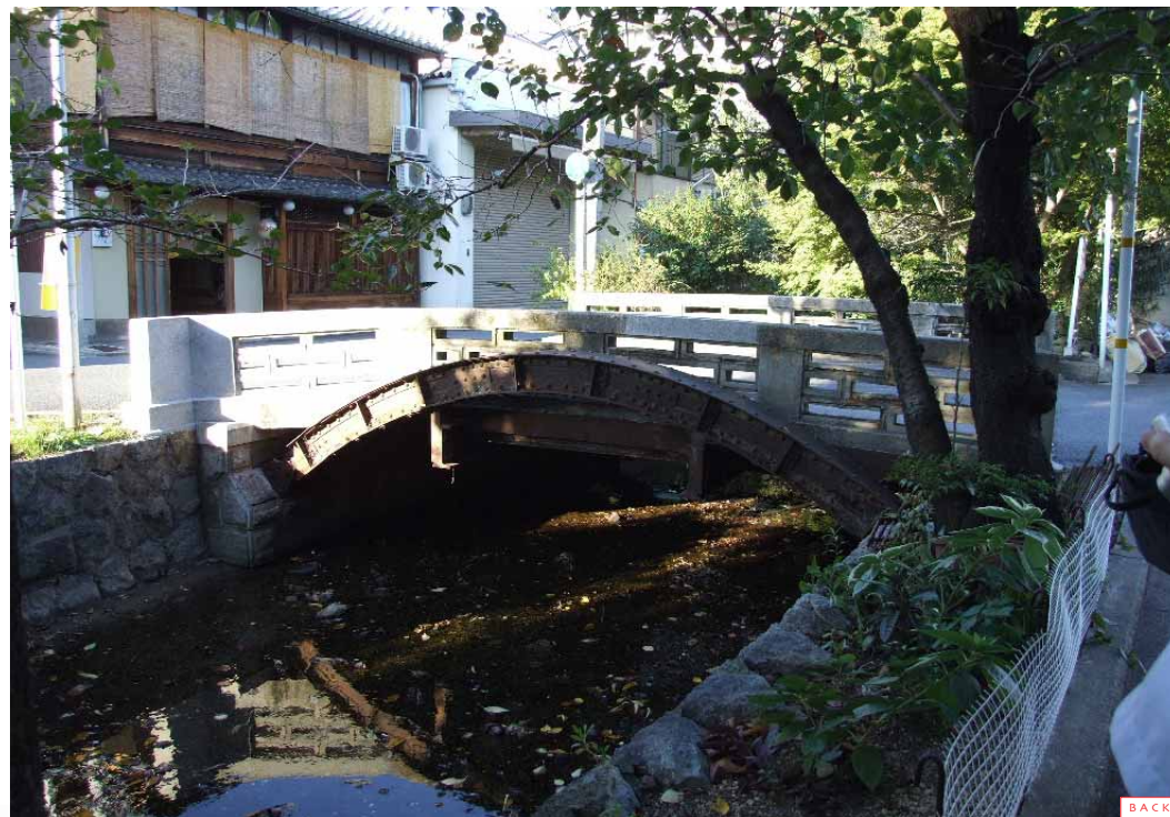
これが... 探していた六軒橋！ 姿は違えど興味の尽きない構造をしている
