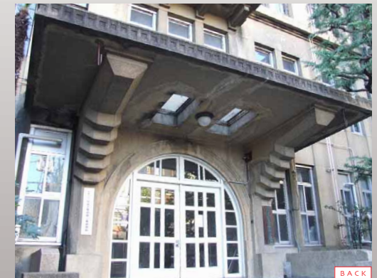
旧立誠小学校 設計：京都市営繕課 鉄筋コンクリート造4階建
