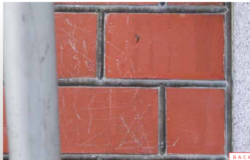
小口積みの壁面。目地の仕上げが丁寧！
