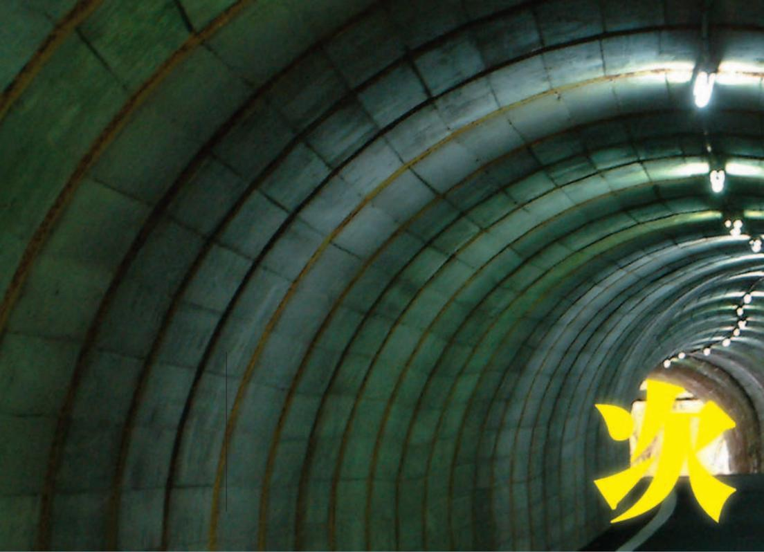
**阿手隧道。**石川県小松市尾小屋町の**尾小屋鉱山**と、山隣の白山市**阿手町**の間にあった明治隧道。延長は**推定700m**。明治時代に作られた**道路用隧道**では栗子隧道に次ぐ**2番目の長さ**を誇った。「明治工業史・土木編」ではその北の**鳥越隧道**のことと記されているが、**違う**。鳥越隧道は**当時から300mクラス**だった。
